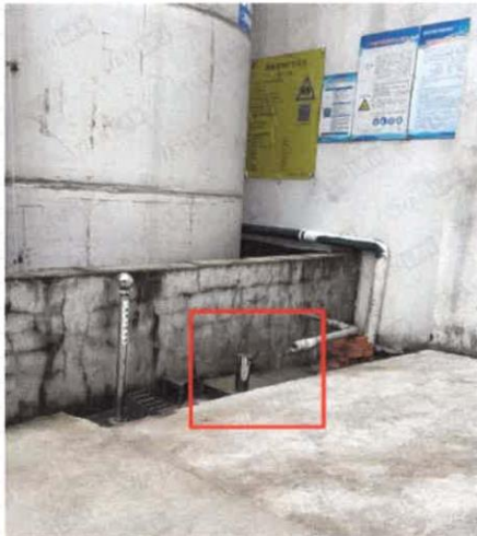
储罐区北侧 D1 (现有)
