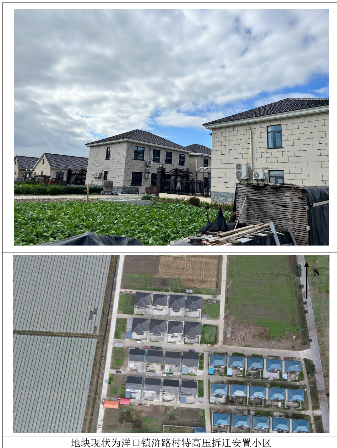
图 3.3-1 现场踏勘情况
