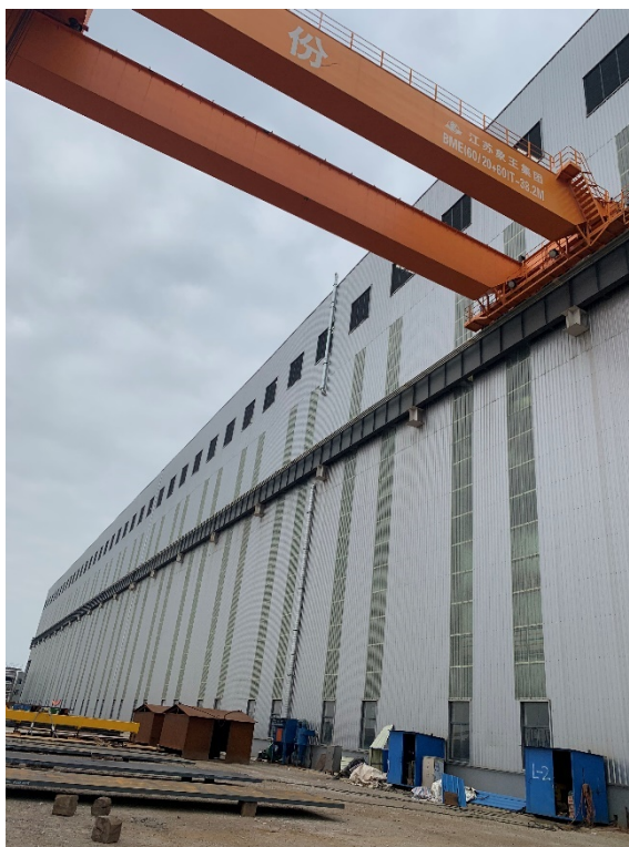
切割废气处理设施
