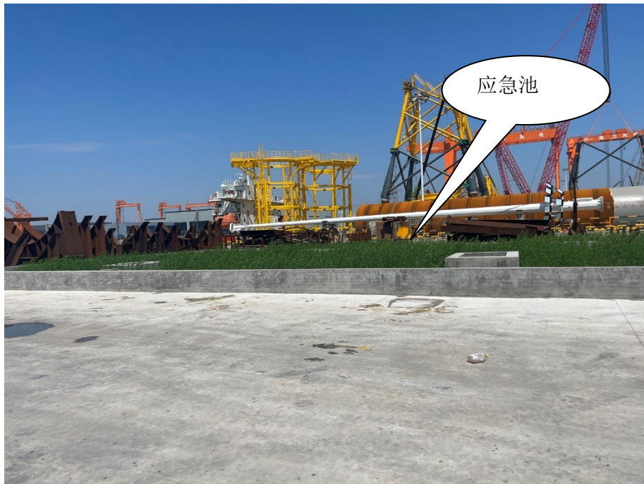
事故应急池照片
