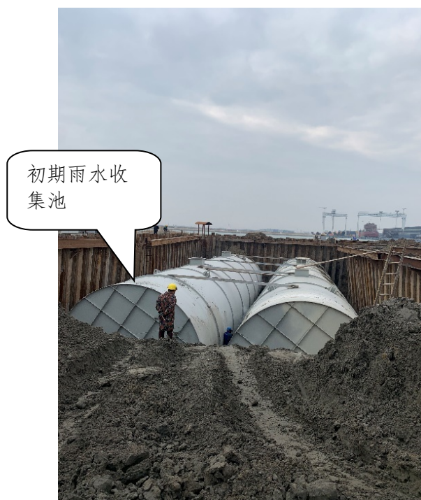
初期雨水收集池
