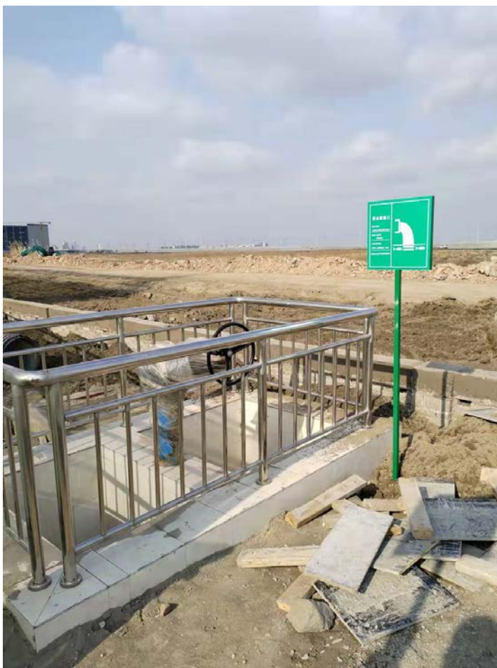
雨水排口标志牌
