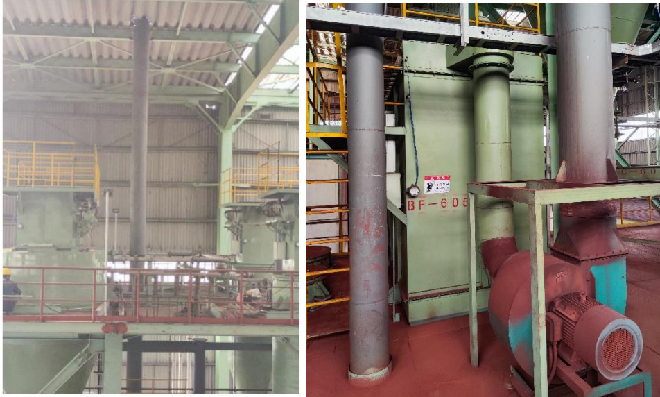
图 3-2 料仓呼吸及配料、混合、振磨、造球及各工序输料废气脉冲布袋除尘装置及排气筒照片
