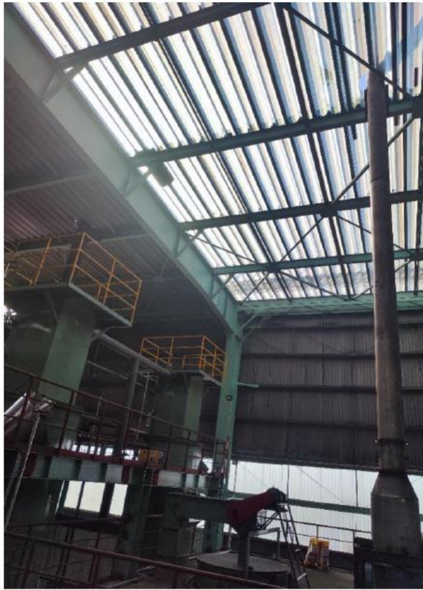
图 3-4 烘干、预烧天然气燃烧废气排气筒照片
