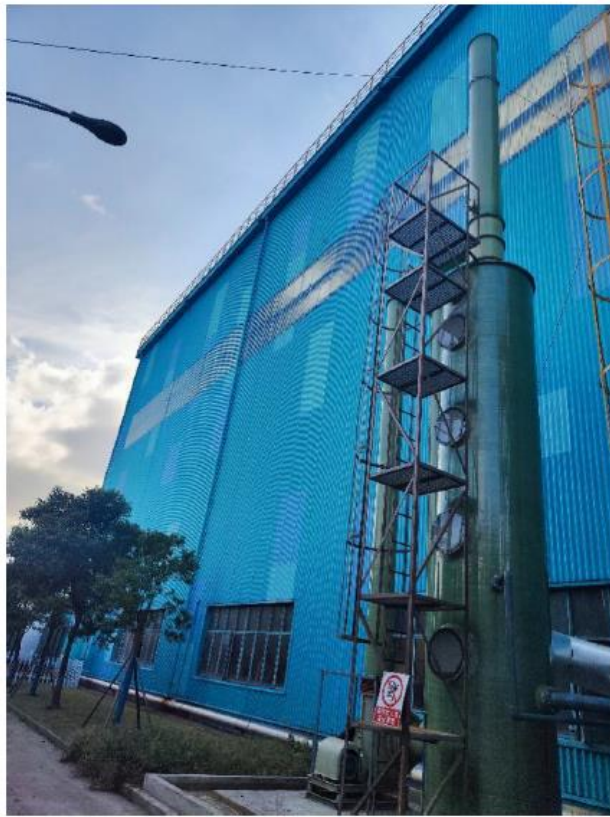
图 3-3 烘干、预烧废气碱喷淋塔及排气筒照片
