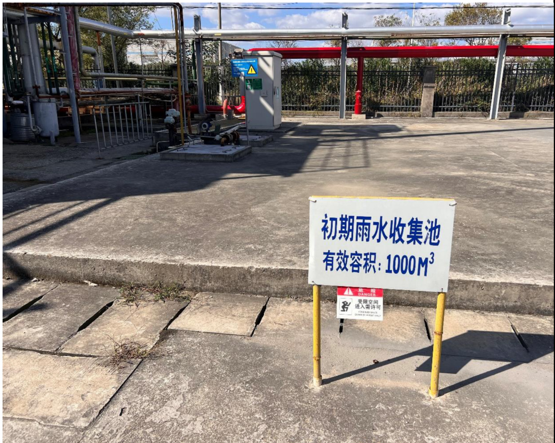
图 3-9 初期雨水池照片
