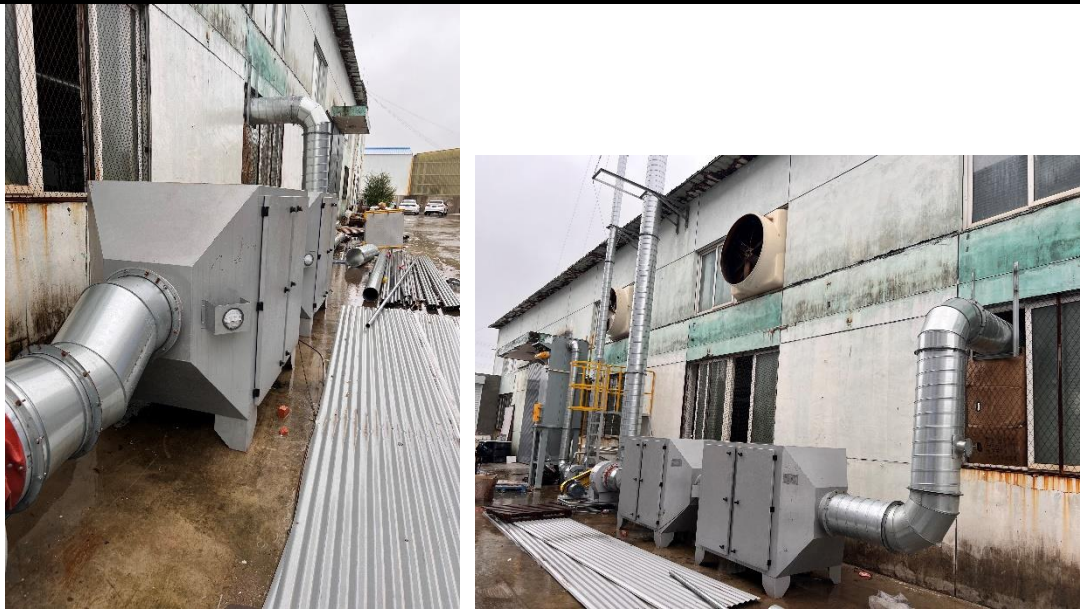
图 3-3 滴塑成型废气处理设施照片
