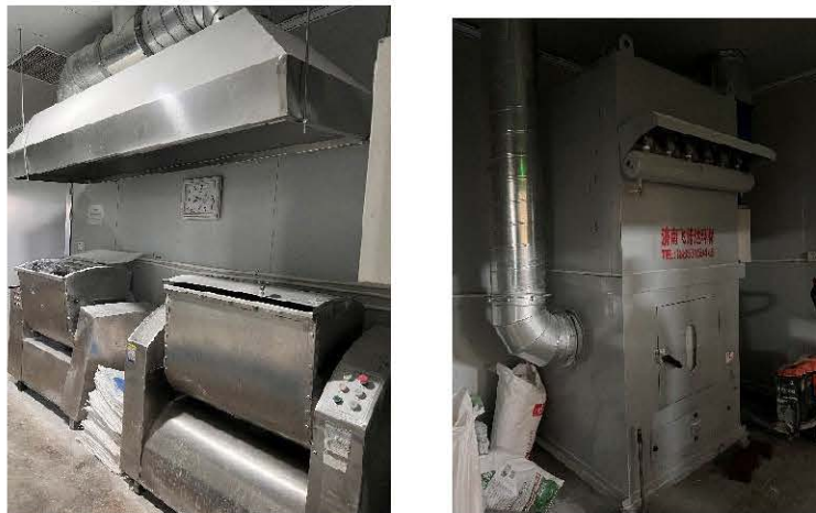
图 3-2 投料废气集气罩收集装置及布袋除尘装置
