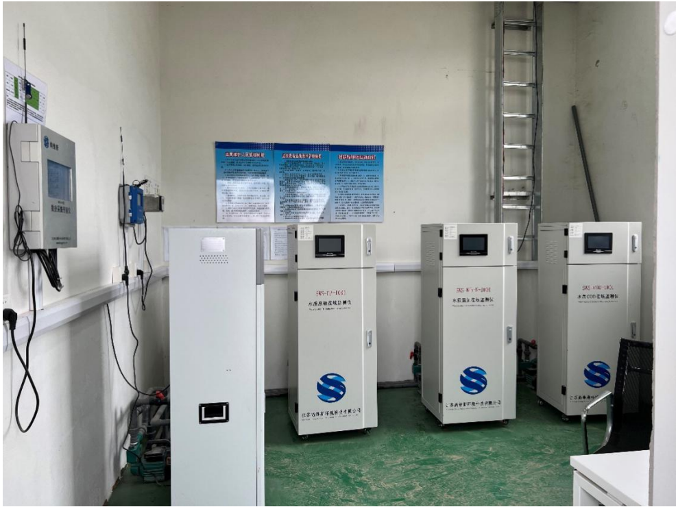
废水排放口自动监控系统照片
