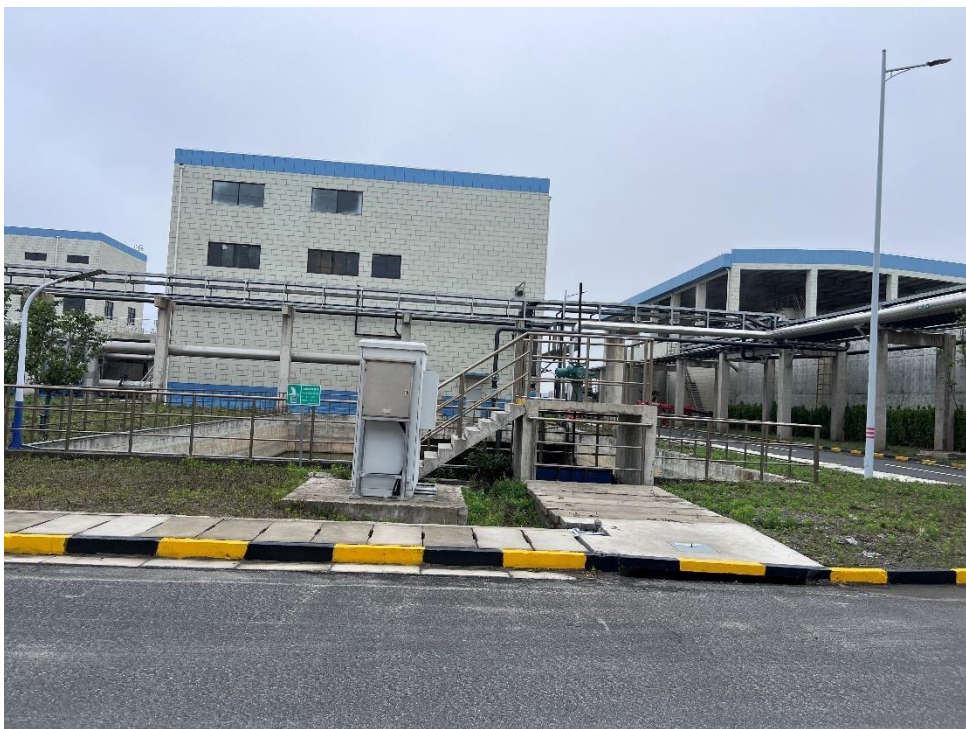
4#雨水排出口照片
