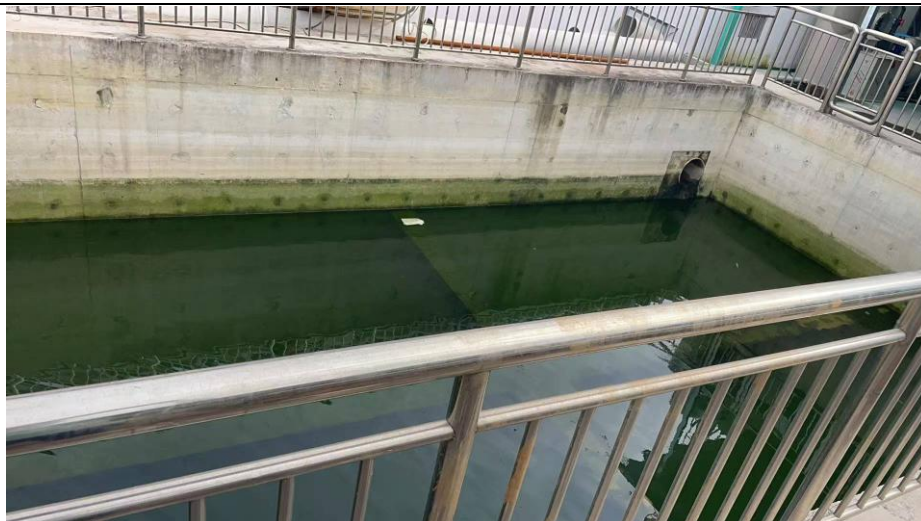
图4.1-3 初期雨水池照片
