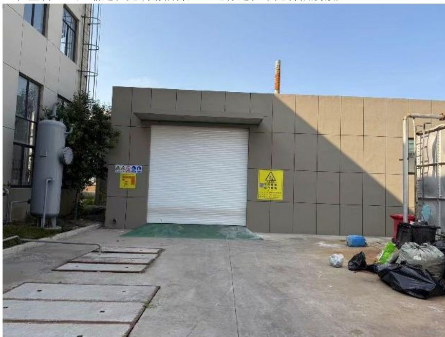
危废仓库外部照片
