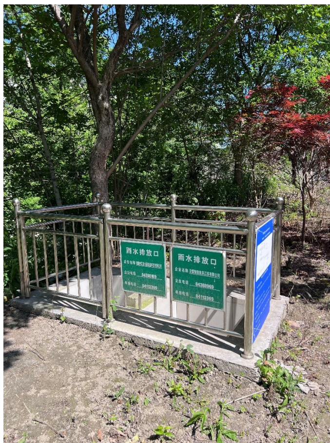
图 3-9 雨水排放口及标志牌照片
