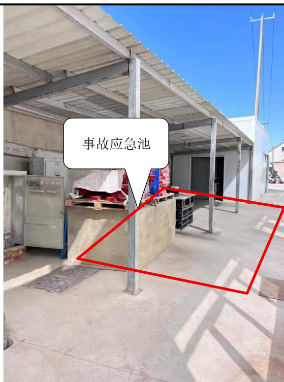
图 3-11 事故应急池照片
