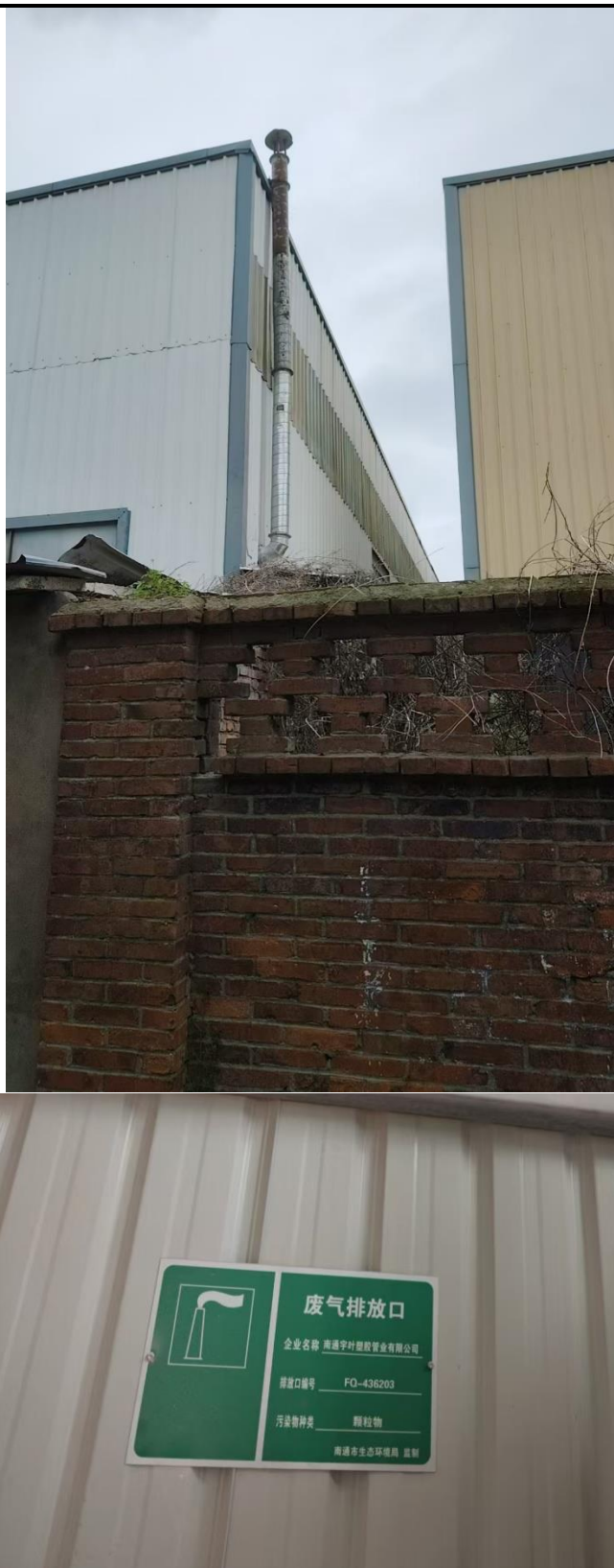
图 3-8 粉碎、研磨废气处理设施 FQ-436203 排气筒标识牌照片
